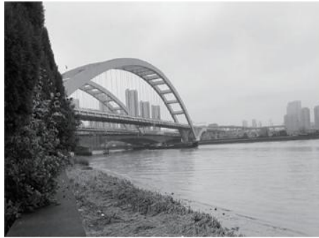
桥梁、物隧道变形监测
